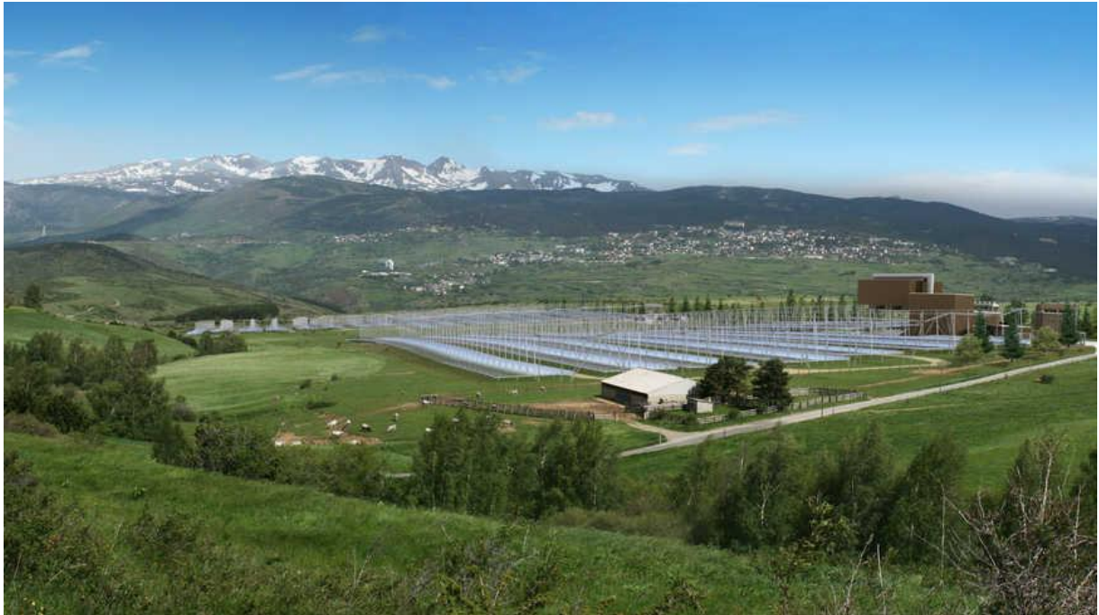
Figure 3. Document de presse. Source: https://www.francebleu.fr/infos/climat-environnement/une-centrale-solaire-unique-en-france-va-voir-le-jour-en-cerdagne-1443713569
